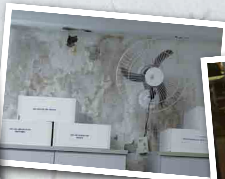
Mofo causado pelas infiltrações já comprometeu paredes de várias salas
