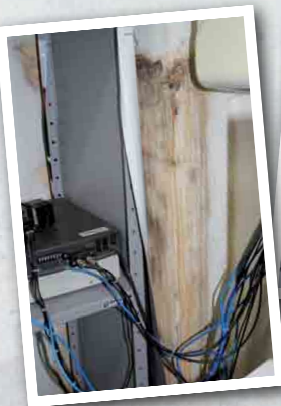
Mofo causado pelas infiltrações já comprometeu paredes de várias salas
