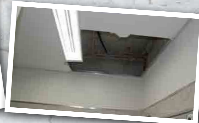
Buraco aberto no teto do banheiro do 3º andar para corrigir vazamento
